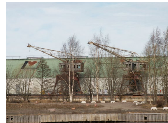
Hamnkranar vid gasverksområdet i Gävle. Foto: Ida Dicksson 2011
