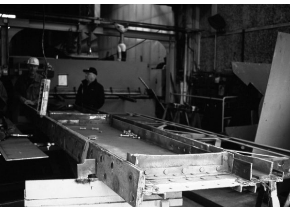
Gotenius Varv har fått i uppdrag att reparera en del av Stora Bommens bro. Bland annat skall de gamla nitarna bytas ut mot nya. Ett avancerat arbete som tar lång tid. Arbetet sker i varvets plåtverkstad.
