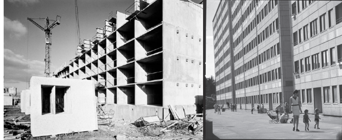
De rationella byggmetoderna i betongelement skapade 8 000 lägenheter per år i slutet av 1960-talet. Foto: Göteborgs stadsmuseum.
