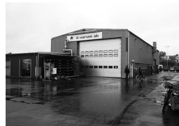
Ö-varvets plåtverkstad och till vänster aluminiumverkstaden. Plåtverkstaden var en av de första byggnader som de nuvarande ägarna, Peder, Örjan och Jonas Backman, lät uppföra när de hade övertagit varvet. Plåtverkstaden uppfördes 1992 och 2016 uppfördes den angränsande aluminiumverkstaden. Foto: Christine Fredriksen 2018.
