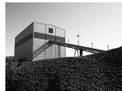
Anrikningsverk för slagg. Foto: Anna Panser, Vänersborgs museum 2018.
